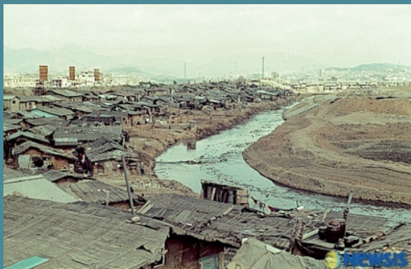
Будівництво автодороги на місці струмка (1958–1976 рр.).
