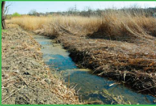
Канал на вул. Бурхана
